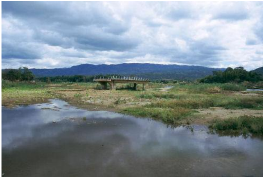
Onderbroken brug over de Dwanga rivier
